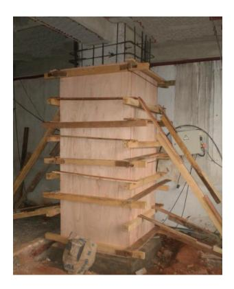
Caso B: Demolición y nuevo hormigonado de pilares a cargo de la constructora. fck 25 MPa fc est 18 MPa f testigos 19 MPa
