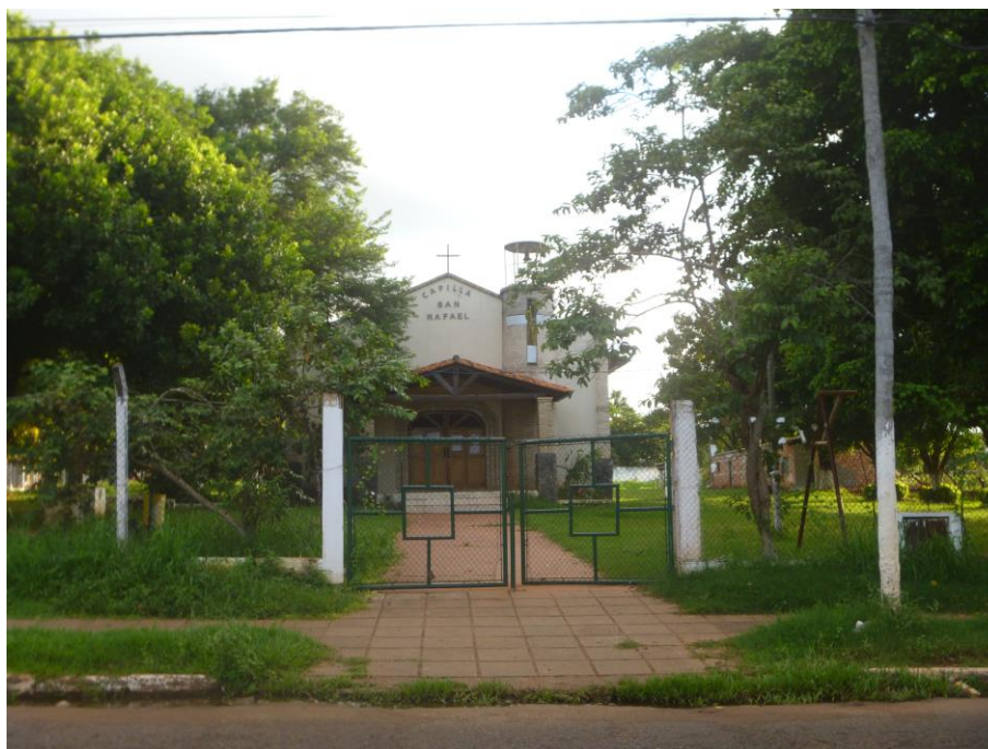
Foto N° 18: Vista General de la Capilla “San Rafael” ubicada en la esquina de las calles Del Maestro y Sto. Tomás , en las proximidades de la propiedad avaluada
