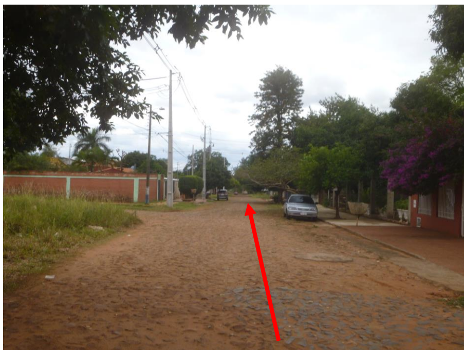
Foto N° 6: Vista General del barrio sobre la calle José Cataldi , hacia la calle Prof. Rosa Ventre (se observan el pavimento empedrado con ligera pendiente en dirección sur-norte hacia la calle Prof. Rosa Ventre , el tipo de edificación existente y el grado de consolidación del barrio)
