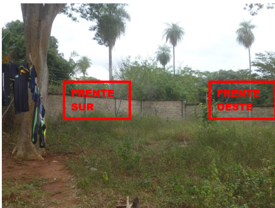
Foto N° 38: Vista General de la propiedad hacia el vértice suroeste (se observan las murallas linderas sur y oeste, la ochava y el tipo de vegetación existente en ese sector del predio)
