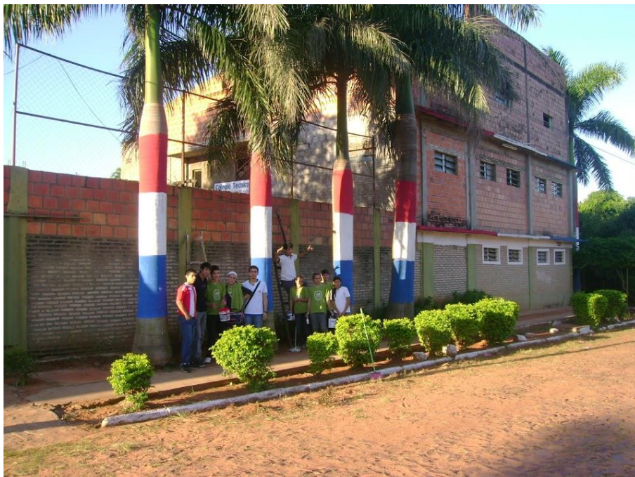
Foto N° 20: Vista General del Colegio Centro Educativo Cristiano “Ciudad Universitaria” , ubicado en la esquina de las calles 24 de Junio y José Rivera , en las proximidades de la propiedad avaluada
