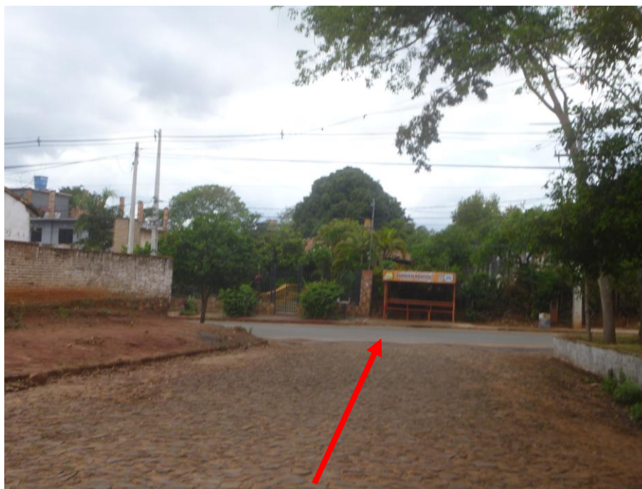
Foto N° 15: Vista General del barrio sobre la calle Prof. Rosa Ventre en su intersección con la calle Brasil , en las proximidades de la propiedad avaluada (se observan el pavimento empedrado y asfaltado, el tipo de edificación existente y el grado de consolidación del barrio)
