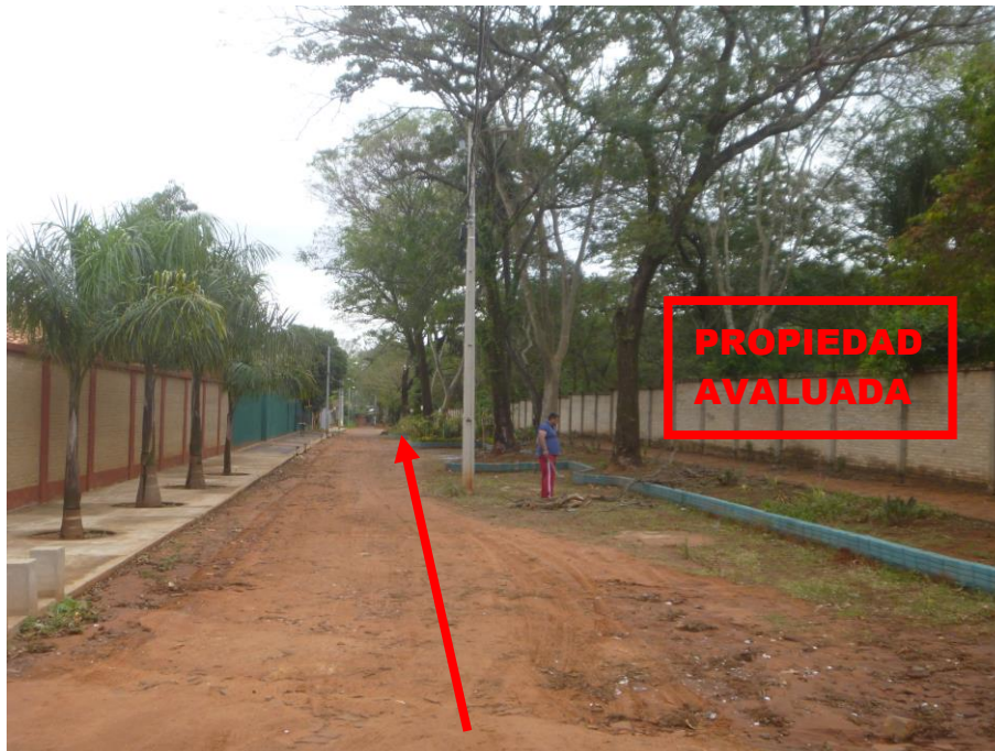
Foto N° 5: Vista General del barrio sobre la calle Prof. Rosa Masi , hacia la calle Rep. Argentina (se observan el frente norte de la Propiedad Avaluada, el pavimento empedrado con ligera pendiente en dirección oeste-este hacia la calle Brasil , el tipo de edificación existente y el grado de consolidación del barrio)
