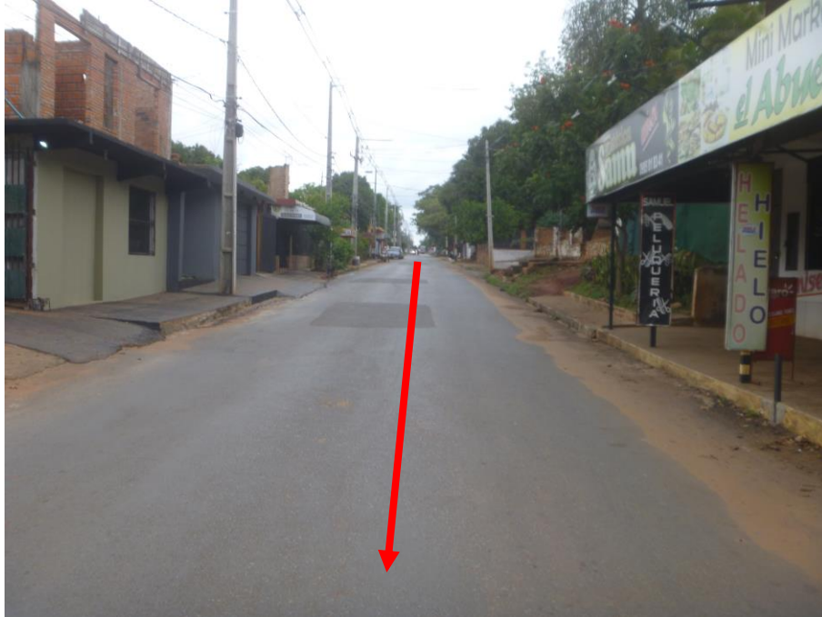
Foto N° 1: Vista General del barrio sobre la calle Brasil , hacia la calle Andrés Salomón (se observan el pavimento asfaltado con ligera pendiente en dirección sur-norte hacia la calle Prof. Rosa Masi , el tipo de edificación existente y el grado de consolidación del barrio)
