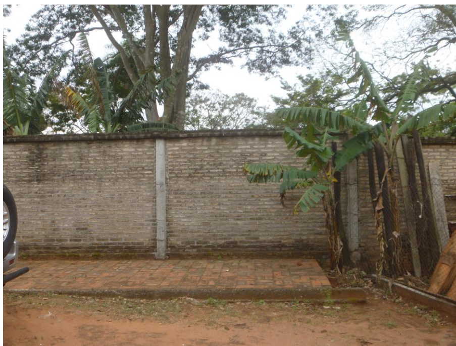
Foto N° 28: Vista General del frente sur de la propiedad sobre la calle Andrés Salomón (se observan la propiedad lindera edificada, la muralla de ladrillos comunes con pilares de hormigón armado, la vereda y el pavimento empedrado)
