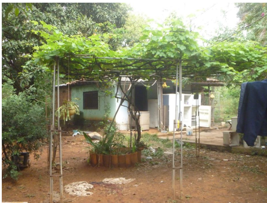
Foto N° 30: Vista General de una de las edificaciones sin valor comercial, ubicada dentro del predio (se observan el parral de uvas, el caminero peatonal que comunica las edificaciones existentes y el tipo de vegetación existente en ese sector del predio)
