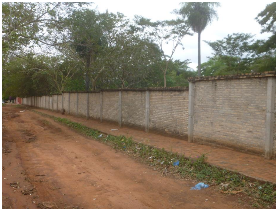
Foto N° 26: Vista General del frente oeste de la propiedad sobre la calle José Cataldi (se observan la muralla de ladrillos comunes con pilares de hormigón armado, el tipo de vegetación existente en ese sector del predio, la vereda y el pavimento terraplenado)
