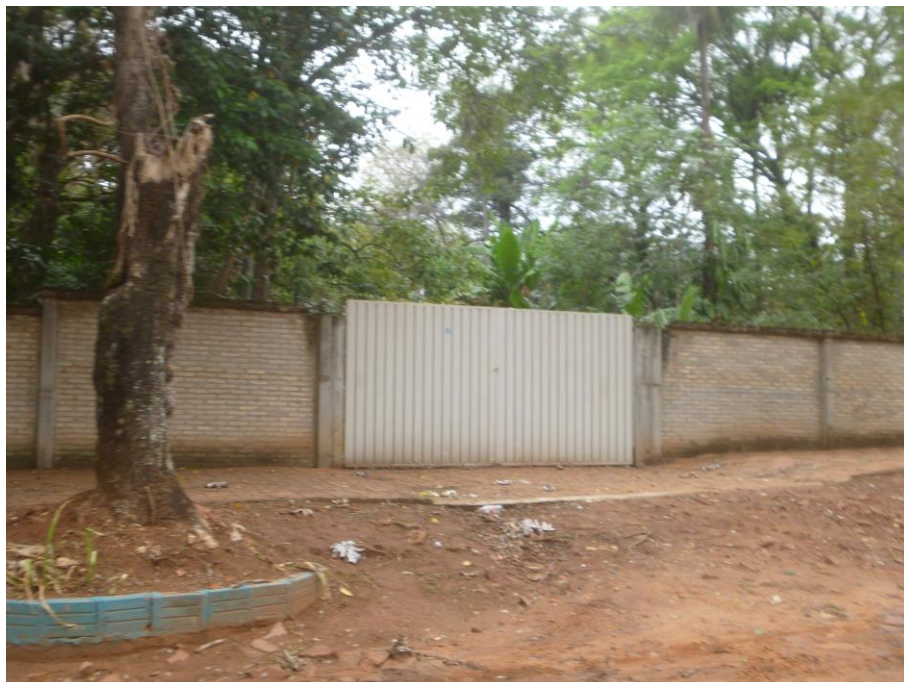
Foto N° 24: Vista General del frente norte de la propiedad sobre la calle Prof. Rosa Masi (se observan la muralla de ladrillos comunes vistos con pilares de hormigón armado, el portón de acceso vehicular, la vereda y el pavimento empedrado)
