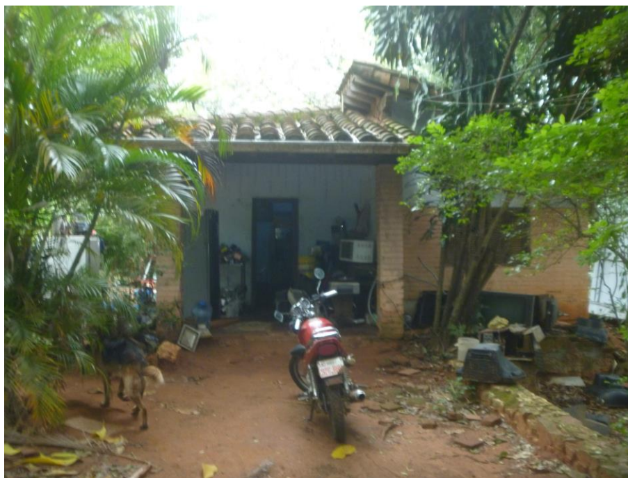
Foto N° 29: Vista General de una de las edificaciones sin valor comercial, ubicada dentro del predio (se observa la galería)
